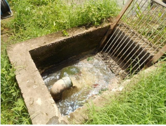
Figure 2.1 - Prétraitement : dégrilleur
