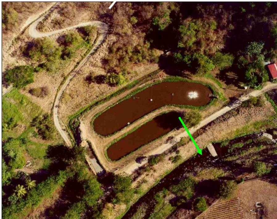
Figure 1.1 - Vue aérienne des lagunes (CG 972, SCE – 2001)
